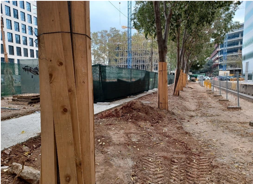
Protección de arbolado de las obras.
