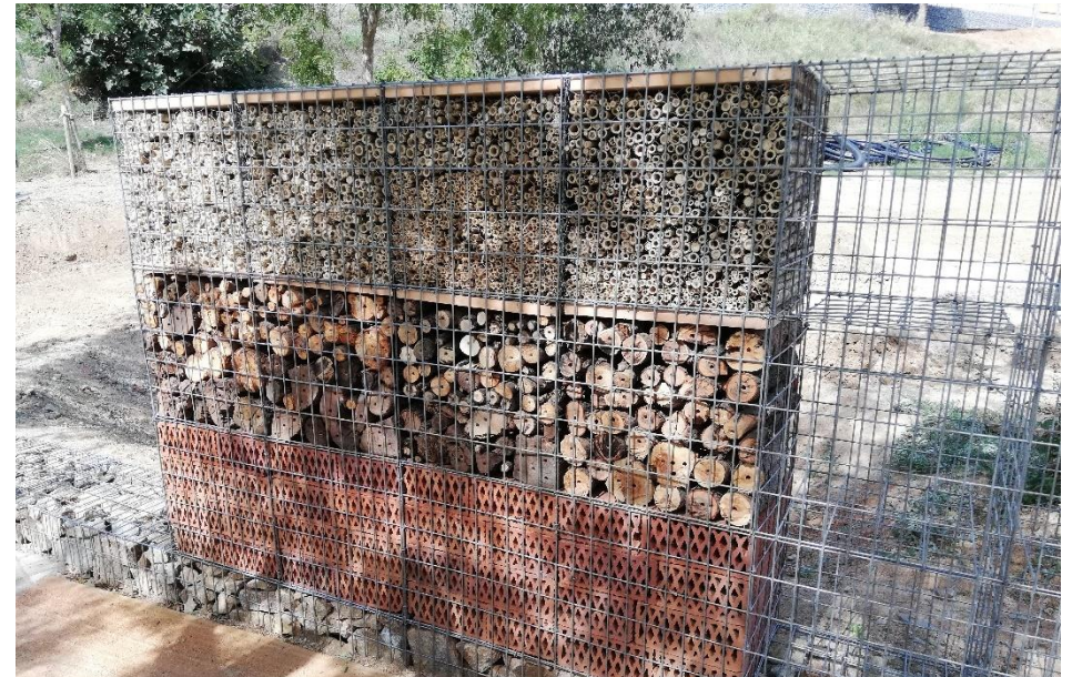
Zona para protección y reproducción de insectos llamado comúnmente como "hotel de insectos", en la obra de Conexión para peatones y arreglo de talud en c/Oristà (Montcada y Reixac, BCN)
