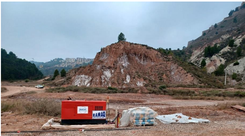
Protección de suelos para minimizar la contaminación por aceites o combustibles.
